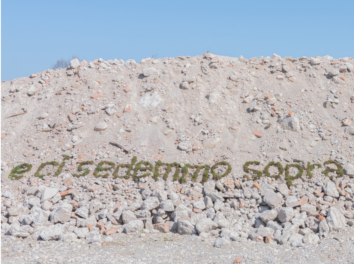
Monaci Demolizioni Speciali Srl Dettaglio_1
