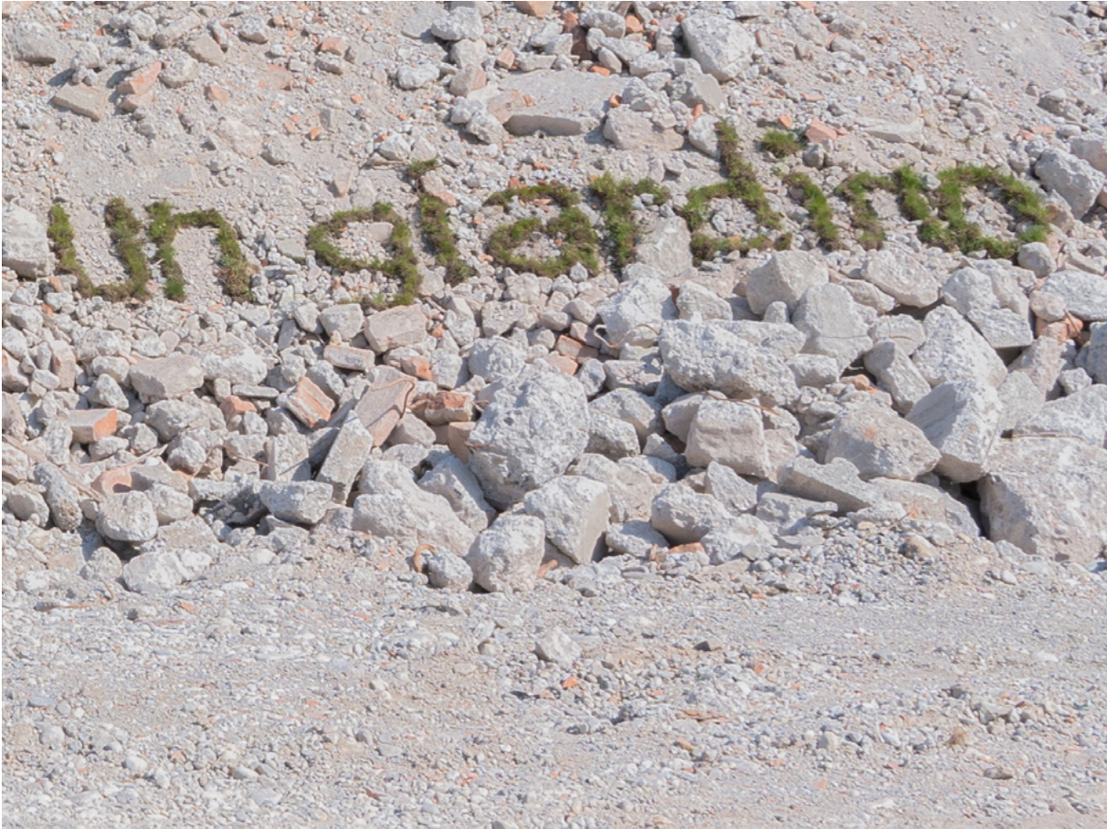
Monaci Demolizioni Speciali Srl Dettaglio_2
