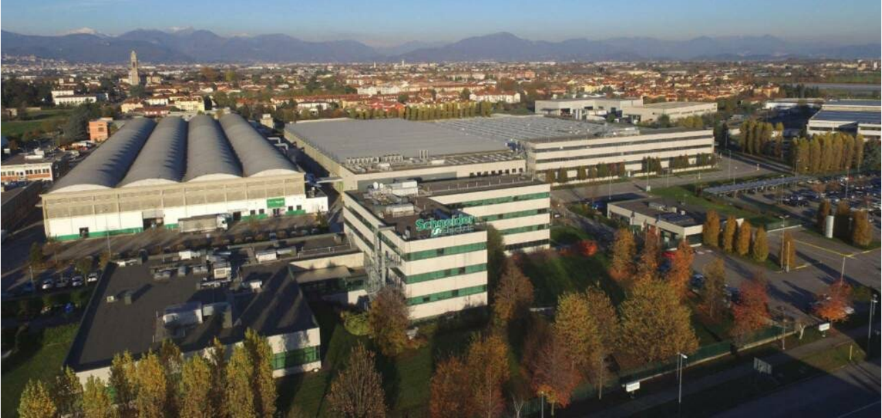
Figure 2: Vista esterna dell'edificio di Stezzano (BG).
