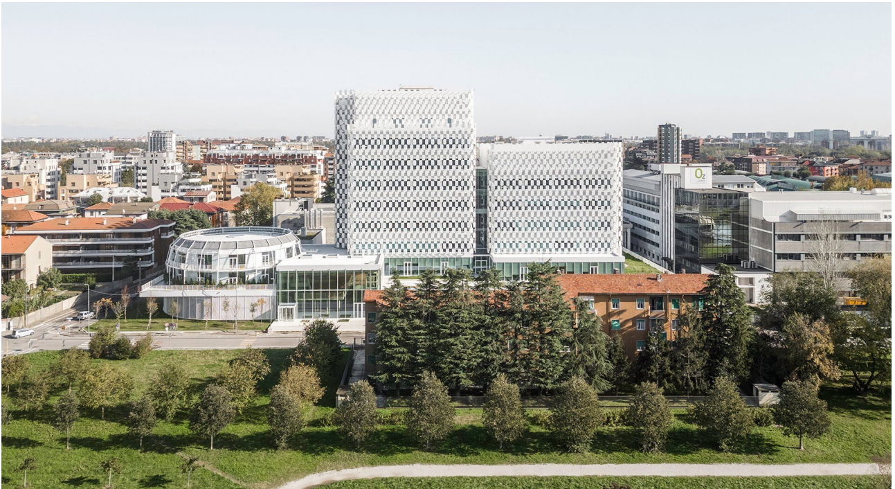
Figura 18. Il Campus scientifico OpenZone, con le due torri per i laboratori e il padiglione circolare per le startup.
