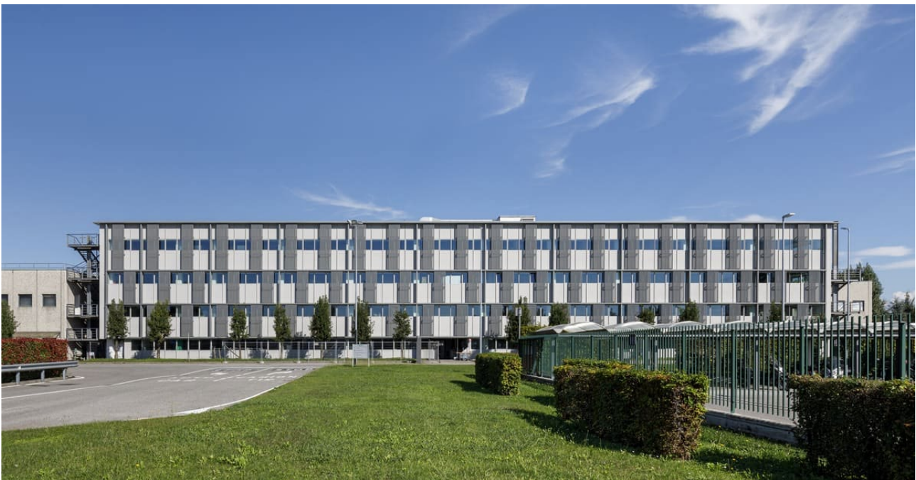
Figura 14. La vecchia e la nuova facciata del sito di Schneider Electric a Stezzano.
