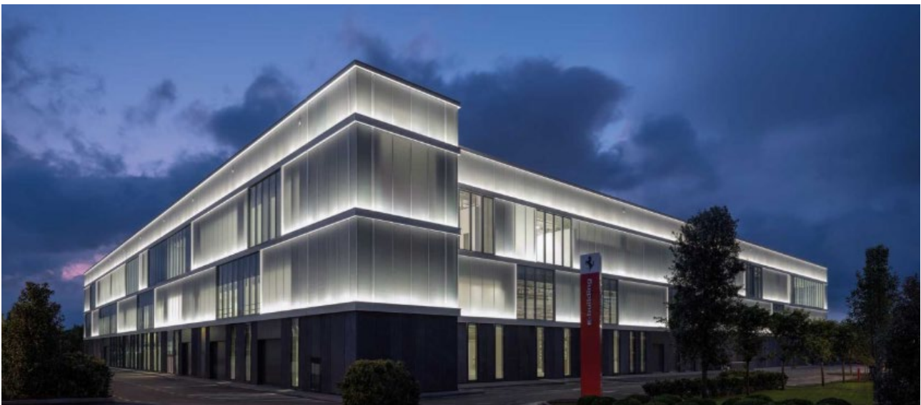
Figura 11. La facciata continua e luminosa costituita da vetrate opaline.
