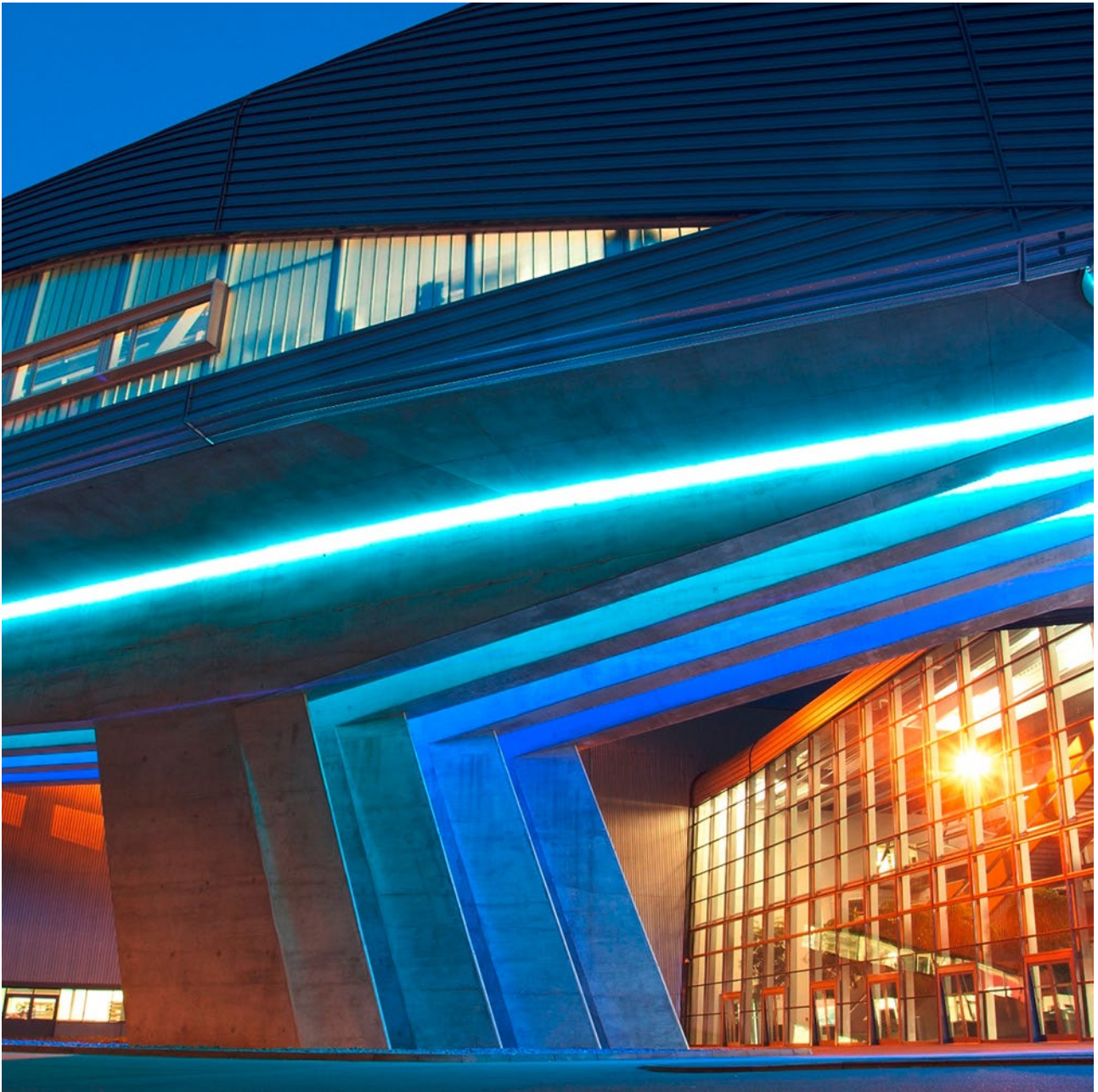
Figura 10. Facciata del Central Building.
