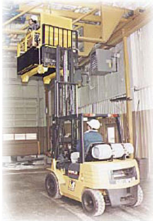
Fig. 7 — Esempio di cesta per il sollevamento di persone 53
