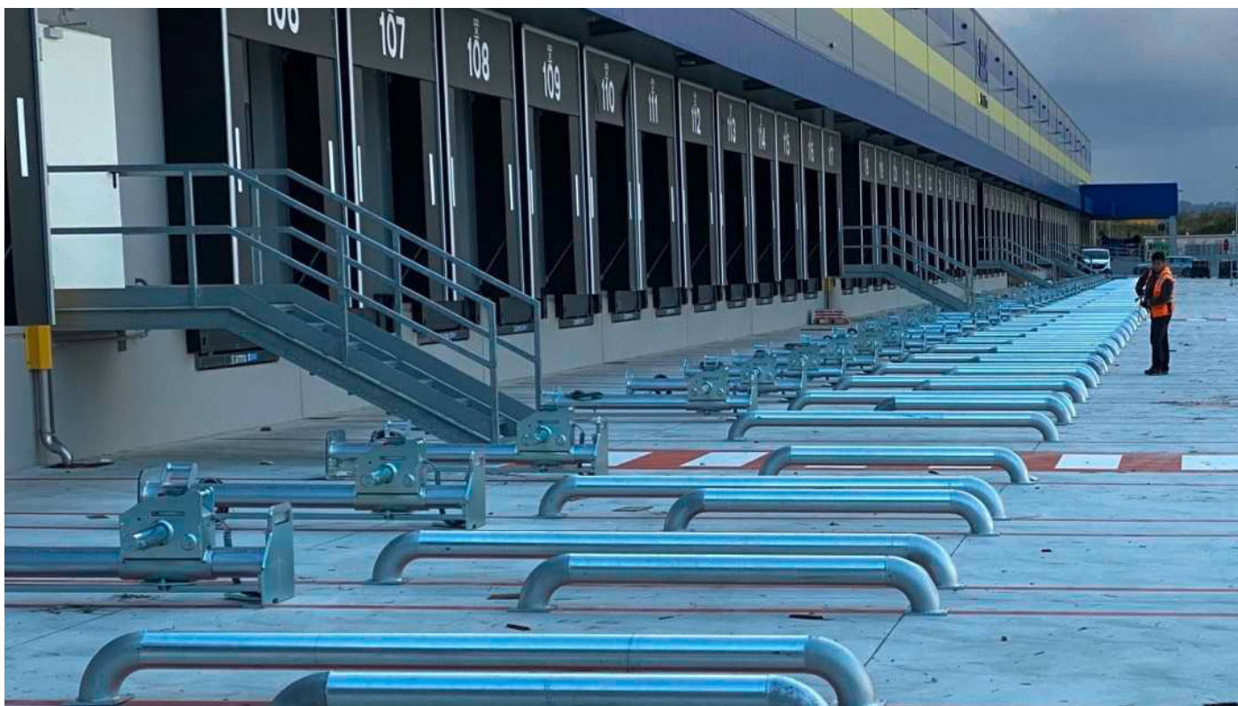
Fig. 26 Accessi pedonali tra gli stalli per consentire il transito tra le banchine di carico esterne e l'interno dello stabilimento, Gli stalli sono provvisti di barriere fisse a protezione dei corridoi pedonali e utili anche al conducente in fase di manovra
