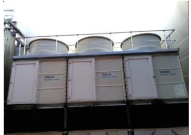
Figura 35: Installazione del dispositivo di protezione collettiva
