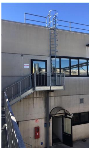
Figura 2: Scala fissa con gabbia e parapetto a protezione dello sbarco Figura 3: Scala fissa con gabbia e scaletta di sbarco
