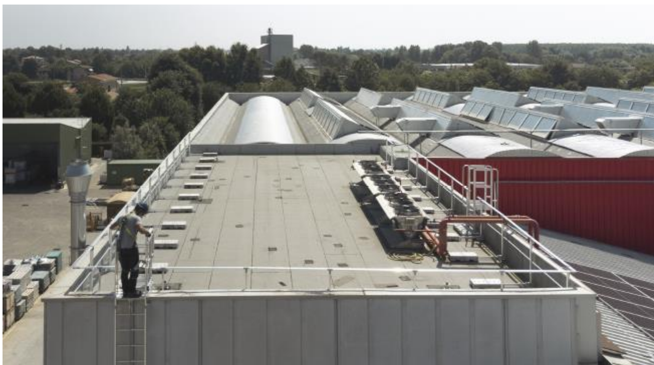
Figura 11: Copertura messa in sicurezza tramite l'installazione di parapetto autoportante. Accesso per mezzo di una scala provvista di dispositivo anticaduta
