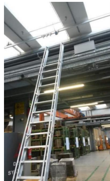
Figura 23: Accesso tramite scala portatile a pioli e accesso reso sicuro da dispositivo di ancoraggio EN 795:2012 tipo D (binario) con retrattile
