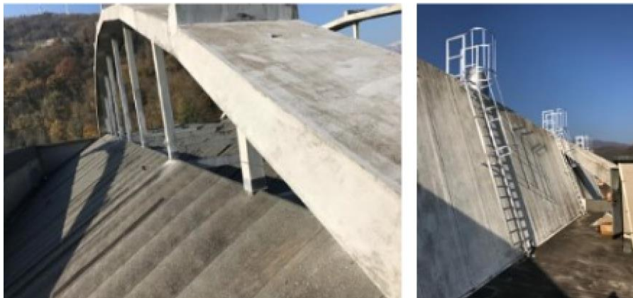
Figure 17a e 17b: Installazione dispositivi di sicurezza e di accesso in sicurezza sulla copertura
