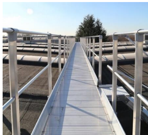
Figura 13: Passerella conforme alla EN ISO 14122-4:2016
