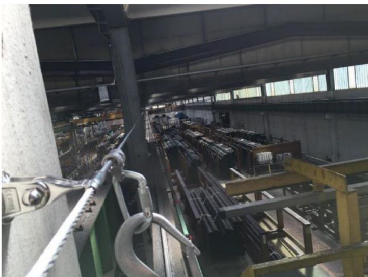
Figura 24 e 25: Dispositivo di ancoraggio EN 795:2012 tipo C installato sulla via di corsa del carroponte
