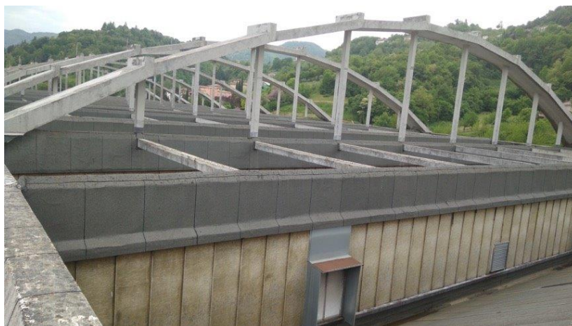
Figura 16a: Copertura di un'industria tessile manifatturiera da mettere in sicurezza
