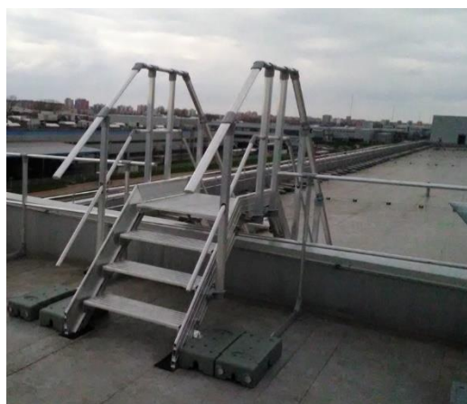
Figura 12: scavalco conforme alla EN ISO 14122-4:2016
