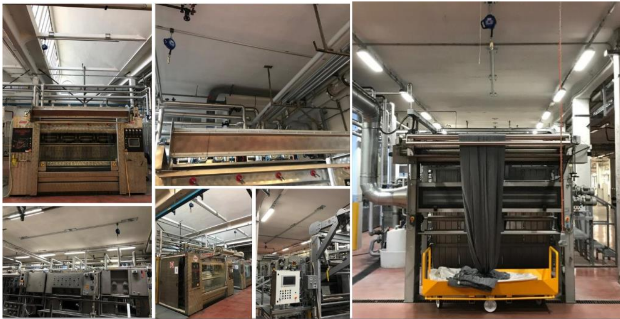
Figura 20: Installazione dei dispositivi di ancoraggio conformi alla EN 795:2012 tipo D
