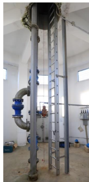
Figura 4: Scala fissa con gabbia con binario anticaduta integrato nel montante e dispositivo anticaduta GTFA
