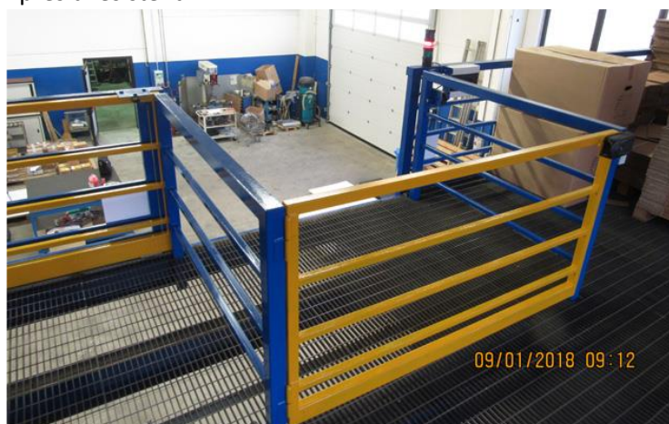
Figura 29: Baia di carico delimitata da due cancelli
