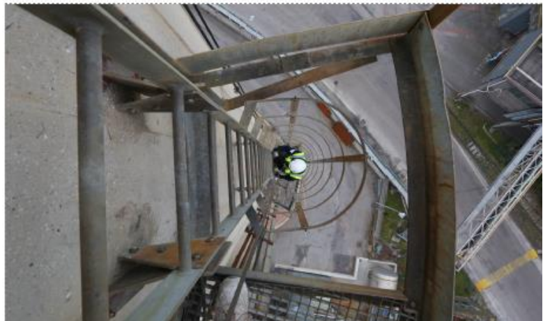
Figura 36: Installazione linea vita verticale per la messa in sicurezza di una ciminiera
