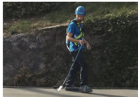
Figura 14: Dispositivo di ancoraggio EN 795:2012 tipo C con dispositivo mobile di ancoraggio
