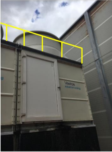
Figura 34: Progetto messa in sicurezza con parapetto
