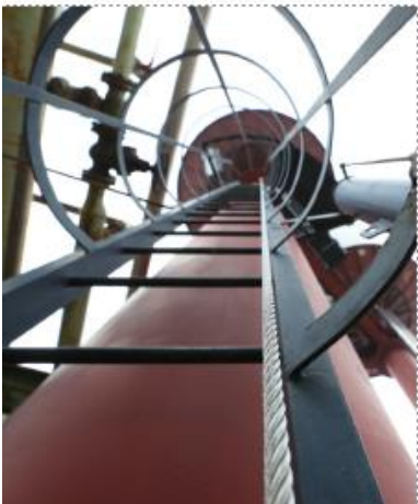
Figura 36: Installazione linea vita verticale per la messa in sicurezza di una ciminiera
