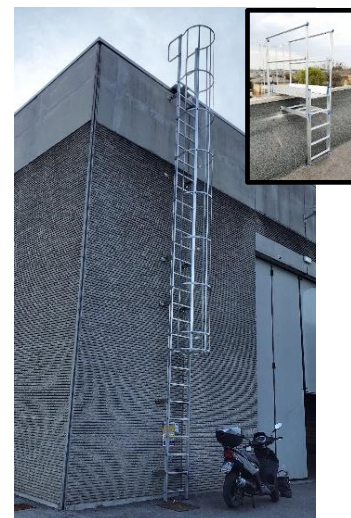
Figura 2: Scala fissa con gabbia e parapetto a protezione dello sbarco Figura 3: Scala fissa con gabbia e scaletta di sbarco
