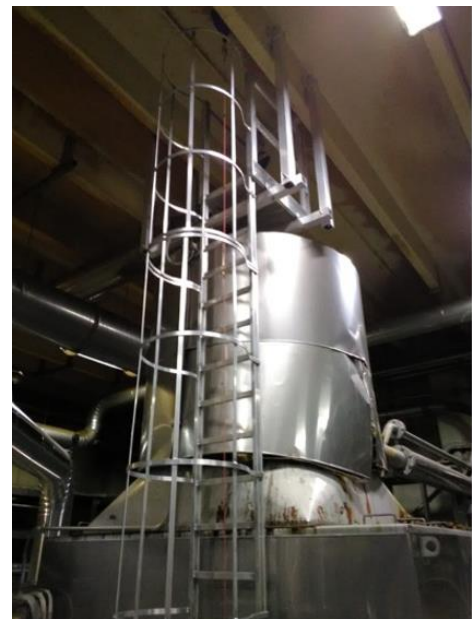
Figura 18: Messa in sicurezza di un macchinario tramite l'installazione di scala a gabbia con retrattile
